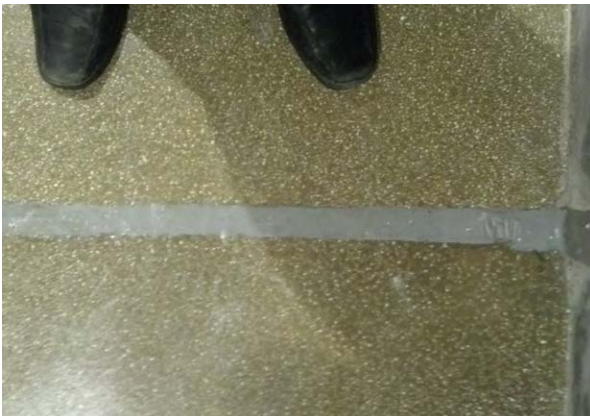
Detalhes da junta de movimentação
