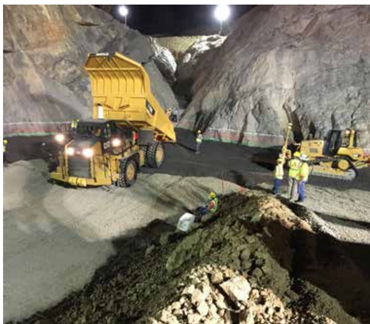
OROVILLE DAM, USA
